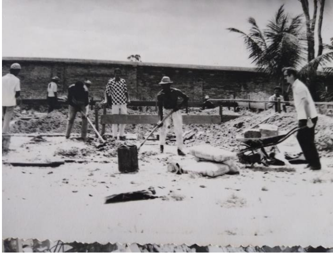
Figura 5. Construção da primeira sede do Coral Santo Antônio.
